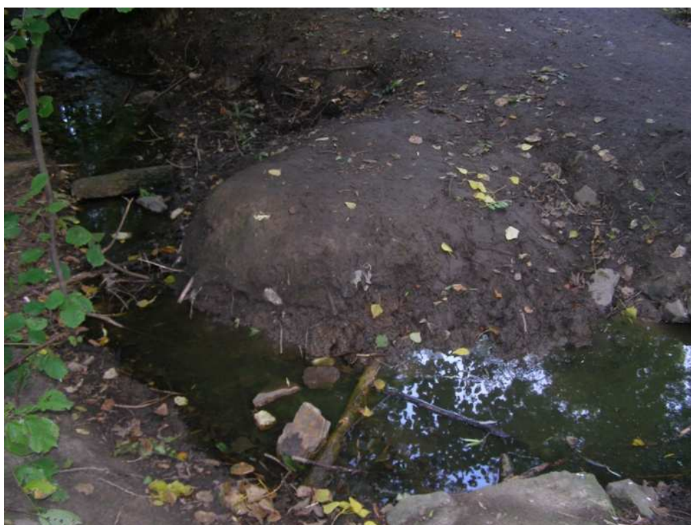
Plocha č. 5 – rozdělovací objekt před Litovickým rybníkem
